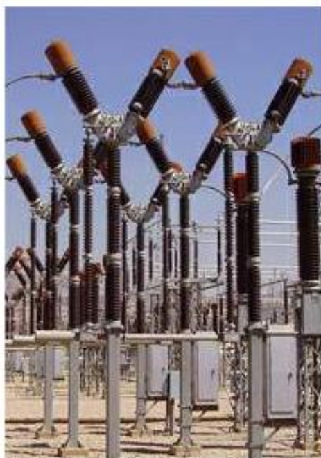
شکل 1-29: متوالی بستن کلیدها برای ولتاژ بالاتر
